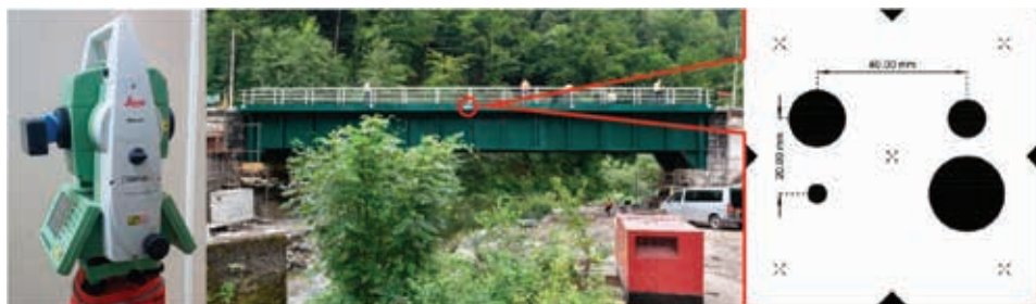
Slika 12. IATS prototip (lijevo), željeznički most Kloštar preko rijeke Dobre (sredina) i foto-oznaka (desno).
